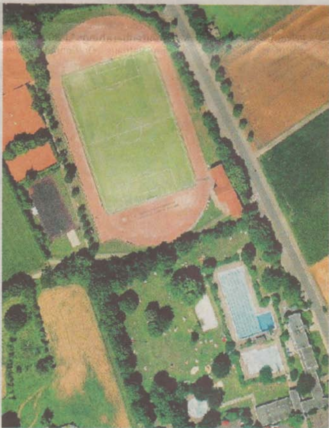
Freibad und Fußballplatz in Sythen sind nur durch einen schmalen Gehölzstreifen getrennt.
